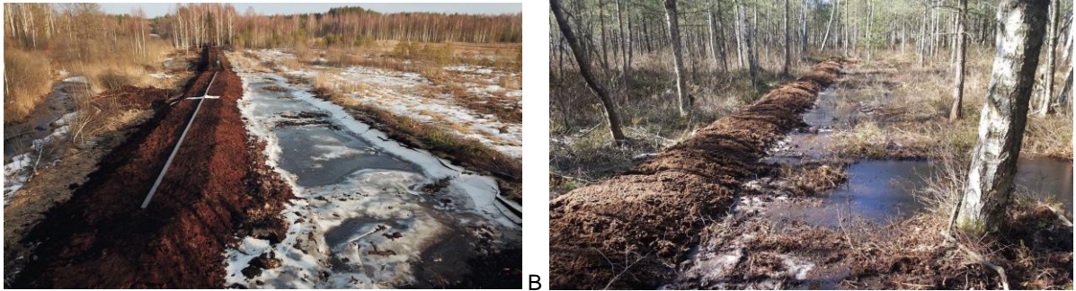
44 pav. Durpių pylimų įrengimas paviršinio vandens nuotėkio sustabdymui Pūsčios durpyne (A) ir Aukštumalos pelkės pietvakarinėje dalyje (B)
