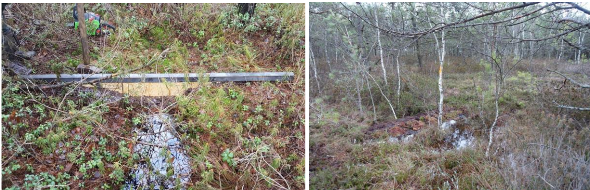
43 pav. Orientuotų skiedrų plokštės (OSB) uždūros, kuriomis patvenkti sausinamieji grioveliai Aukštumos telmologinio draustinio PV dalyje, 2021 m.
