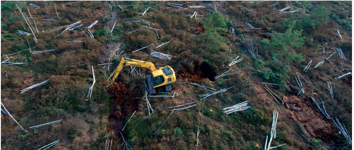
41 pav. Durpių uztūros įrengimas naudojant techniką. Šaltinis: Zableckis ir kt., 2017
