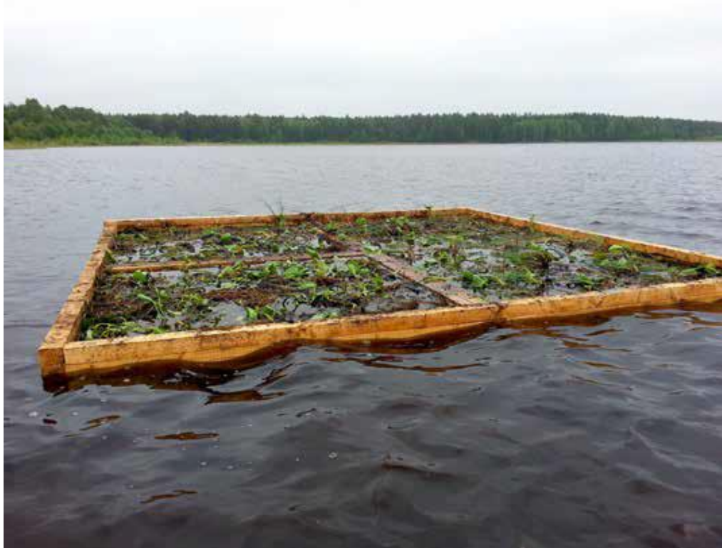
50 pav. Dirbtinės salos įrengimas po durpių eksploatacijos susidariusiame sekliame vandens telkinyje. Wielkie Bagno durpių karjeras, Lenkija. Šaltinis: Pakalne et al., 2021. Nuotrauka: K. Bociąg.
