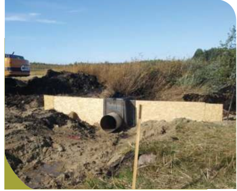
11 pav. Užtvankos su reguliuojama pralaida įrengimas Liepkojų pelkėje, Žuvinto biosferos rezervatas. © Nerijus Zableckis
