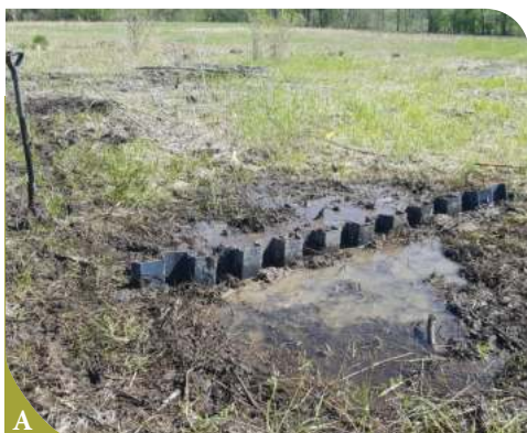
7 pav. Hidrologinio režimo atkūrimo priemonės Tartoko žemapelkėje, Prienai: A – plastikinių sprauslasienių pertvara, B – pertvara iš vidutinio tankio medienos plaušų (MDF) plokštės. © Nerijus Zableckis
