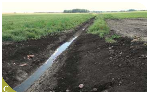
40 pav. Drenažo sistemos pertvarkymas atkuriamame durpyne ir jo aplinkoje, Baisogalos apylinkės, Lietuva, 2022 m.: A–B – šliuzo reguliatoriaus su vienuolio tipo vandens pralaida įrengimas (© UAB Baisogalos statyba, Jūratė Sendžikaitė), C – išvalytas ir performuotas sausinimo griovys (© Jūratė Sendžikaitė), D – pertvarkyti ir į paviršių išvesti drenažo rinktuvai (kairėje) ir patvenktas sausinimo griovys (dešinėje). © Nerijus Zableckis
