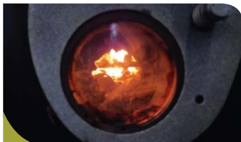
44 pav. Šlapių pievų žolės rulonais kūrenama Malchino katilinė, Vokietija. © Jūratė Sendžikaitė
