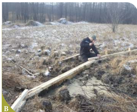
7 pav. Hidrologinio režimo atkūrimo priemonės Tartoko žemapelkėje, Prienai: A – plastikinių sprauslasienių pertvara, B – pertvara iš vidutinio tankio medienos plaušų (MDF) plokštės. © Nerijus Zableckis
