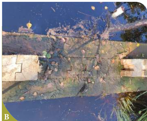
6 pav. Medinių sprauslasienių (plotis 20 cm) pertvara su perteklinio vandens nutekėjimo anga, Svencelės aukštapelkė, Klaipėdos r., 2023 m. © Jūratė Sendžikaitė
