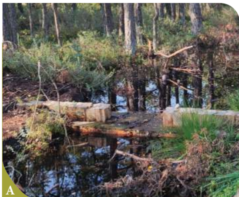
6 pav. Medinių sprauslasienių (plotis 20 cm) pertvara su perteklinio vandens nutekėjimo anga, Svencelės aukštapelkė, Klaipėdos r., 2023 m. © Jūratė Sendžikaitė
