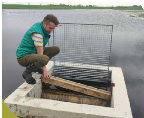
9 pav. Mediniais šandorais reguliuojama užtvanka įrengta atkuriamoje Baisogalos šlapynėje, Radviliškio r. © Jūratė Sendžikaitė
